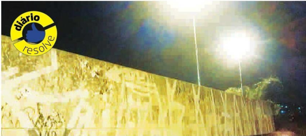
Postes de iluminação com lâmpadas de vapor metálico de 400W foram instalados na entrada e na saída da passarela que cruza a Estação Guaianases do trem
