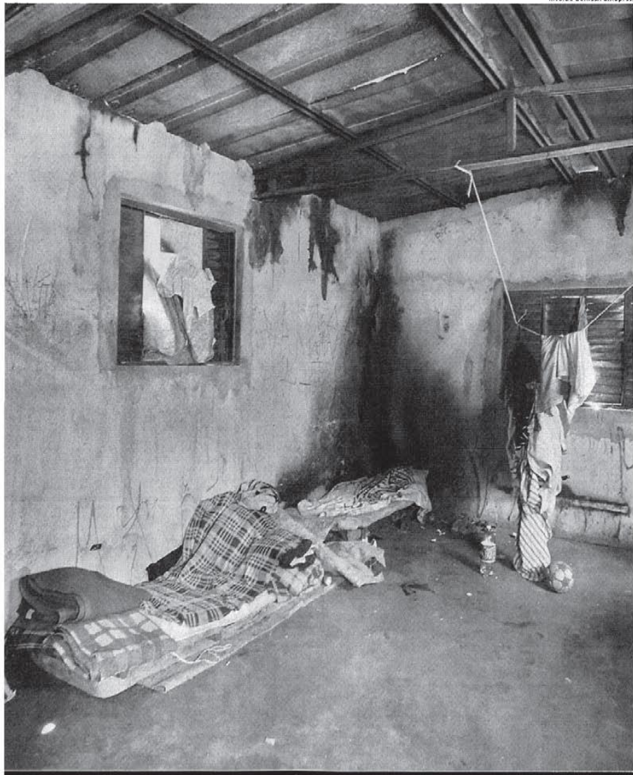
Galpão usado por viciados em crack; pinos de drogas deixados no local (no dest.)
