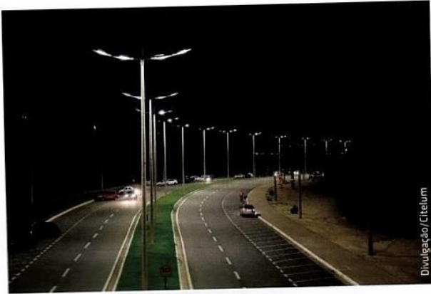
Avenida Litorânea, com iluminação a LED e telegestão, em São Luís (MA).
