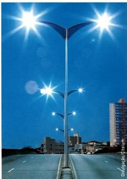
Viaduto Mario Covas, em Mauá (SP). Segundo último levantamento realizado pela Eletrobras, em 2012, a iluminação pública no Brasil possui 16,1 milhões de pontos.
