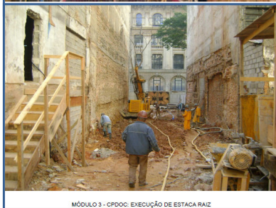
MÓDULO 3 - CPDOC: EXECUÇÃO DE ESTACA RAIZ
