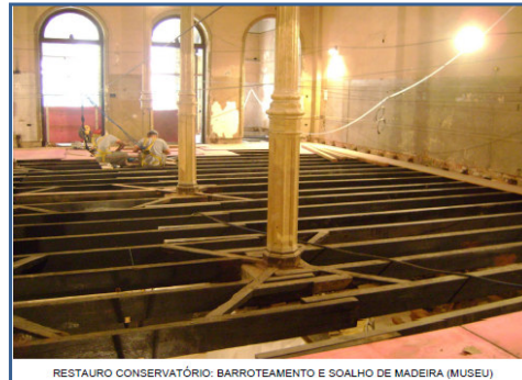
RESTAURAO CONSERVATÓRIO: BARROTEAMENTO E SOALHO DE MADEIRA (MUSEU)
