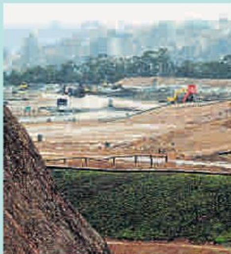
Aterro sanitário de Caieiras, que recebe lixo de SP
