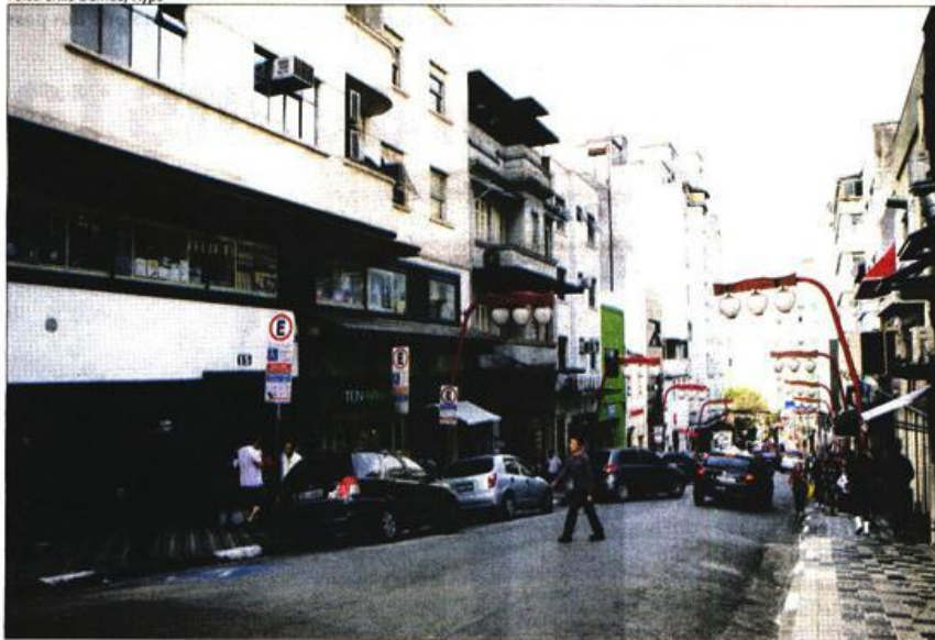
Rua com as tradicionais luminárias japonesas. Acima, à direita, peça com a sanca deteriorada.
