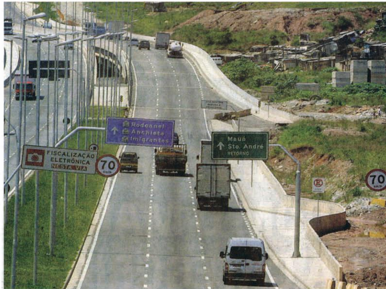
Alternativa ao Trecho Leste do Rodoanel, parte da Jacu-Pêssego é iluminada por geradores movidos a diesel
