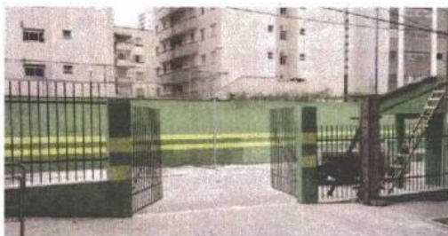
Antes de iniciar operação, novo Ecoponto precisa ter portão ampliado, de quatro para seis metros de largura
