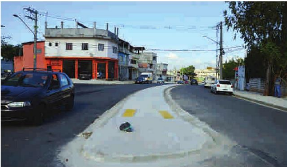
Obras de alargamento e recapeamento da Avenida Abel Tavares, na Zona Leste: investimentos em mobilidade na atual gestão está com números a desejar
