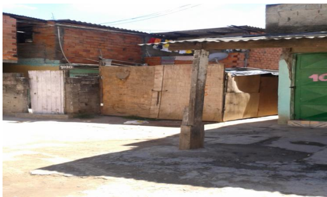
Ocupação irregular situada nas imediações da “Estrada do Iguatemi”.
