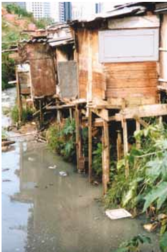
Foto 4.7 - Moradias em favela com tubulação de lançamento de efluentes sanitários em curso d'água.
