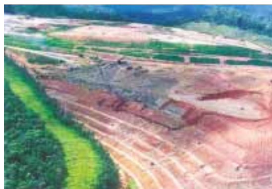
Foto 4.8 - Aterro São João: setor em operação.
