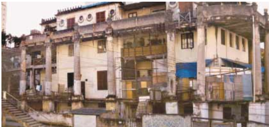
Foto 4.14 - Vista de cortiço situado na rua Martiniano de Carvalho. Distrito da Bela Vista.
