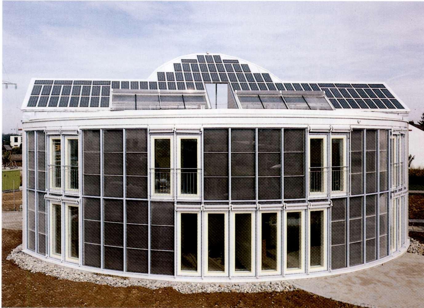
Das Energieautarke Solarhaus. Südansicht. (Quelle: Koslik)
