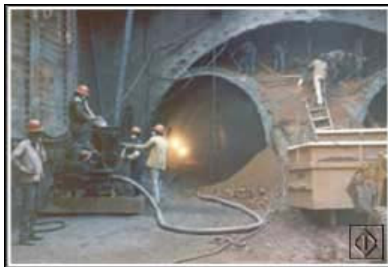
Figura 6 - Execução de túnel NATM
