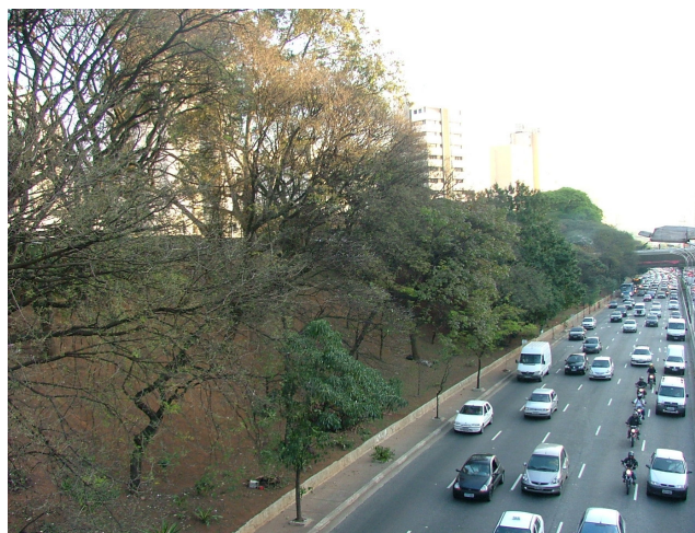
Figura 86 - Vista oposta a anterior, sentido viaduto Eng o Antonio de Carvalho Aguiar.
