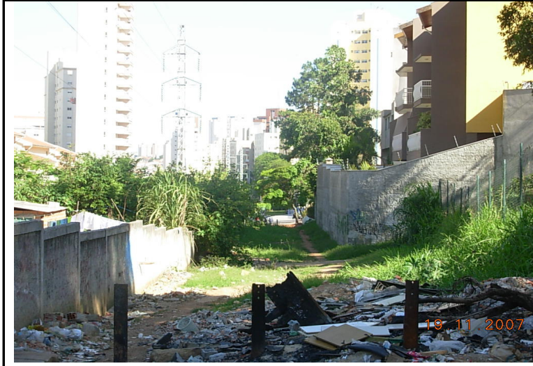
Foto 16 - Vista para viela por onde passa uma linha de transmissão.
