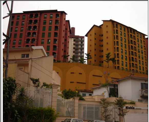
Prédios residenciais localizados na rua Desembargador Aragão, próximo a rua Dr. Barros Cruz que dá acesso à rua Vergueiro
