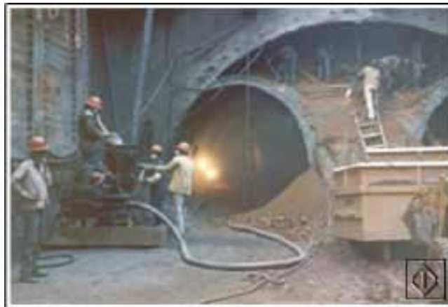
Execução de túnel NATM
