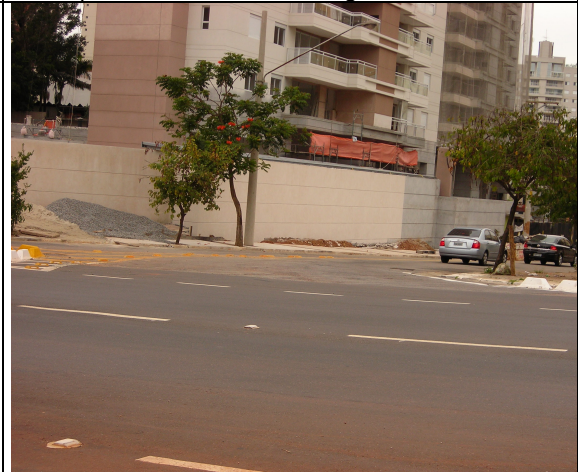
Rua São Gilberto/Embuçu – do lado direito na foto – prédios residenciais em fase de acabamento – área com intensa verticalização.
