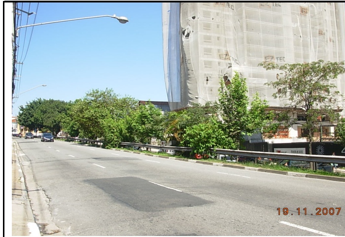
Foto 1 - Vista do início do trecho em estudo (local aproximado de saída do túnel Norte), na avenida Sena Madureira.
