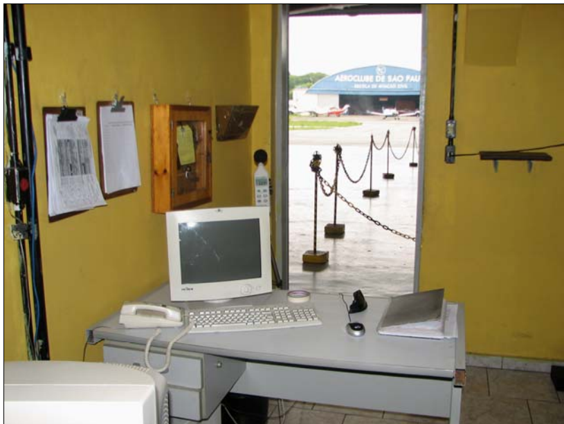
FIGURA 114 SETUP NO LOCAL, INSTALADO DENTRO DA SALA DE MANUTENÇÃO DA PM. AZIMUTE 170° V
