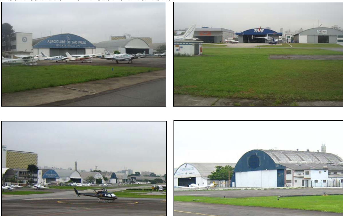
FIGURA 33. HANGARES – VISÃO NO AERÓDROMO
