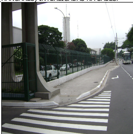
FIGURA 267. EDIFICAÇÕES (HANGARES) INTERLIGADAS NA SABESP
