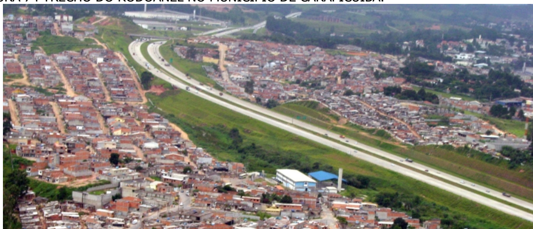
FIGURA 74 TRECHO DO RODOANEL NO MUNICÍPIO DE CARAPICUÍBA.
