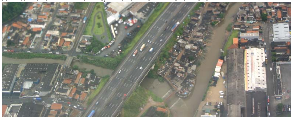
FIGURA 65. RODOVIA FERNÃO DIAS, TRECHO NA GRANDE SÃO PAULO.
