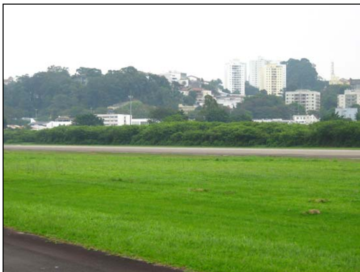
FIGURA 214. PISTA DE DECOLAGEM COM A COTA SUPERIOR À DA SUPERFÍCIE DO TERRENO, "LEVANTADA" POR MEIO DE ATERRO. AO FUNDO MORRO DO JARDIM SÃO BENTO.
