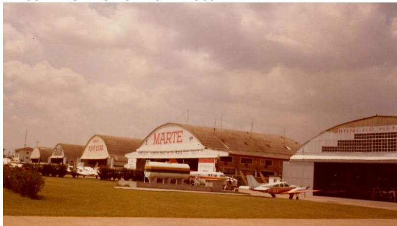
FIGURA 10. VISTA DOS HANGARES NO ANO DE 1980.
