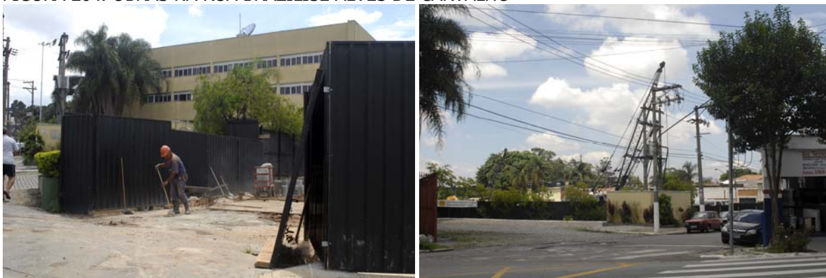
FIGURA 264. OBRAS NA RUA BRAZILISE ALVES DE CARVALHO
