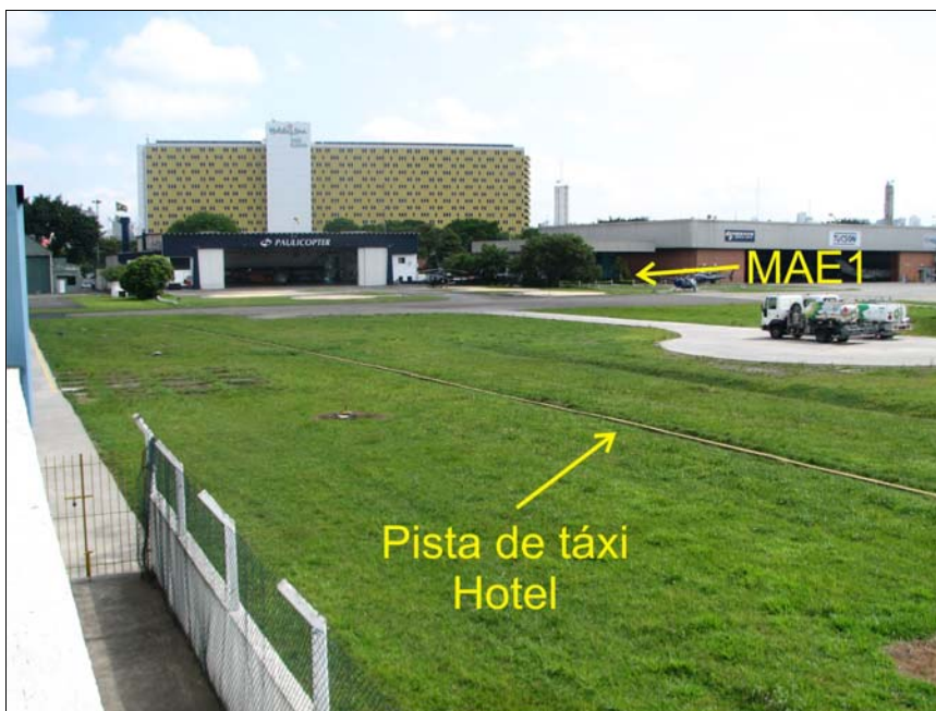
FIGURA 131 VISTA EXTERNA DA SACADA, MOSTRANDO O CAMINHO DEMARCATO EM AMARELO DA PISTA DE TÁXI "HOTEL" AO LONGO DA LATERAL DO HANGAR. NO DETALHE A VISTA DO PONTO MAE1. AZIMUTE 197°V
