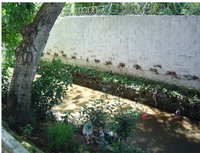
FIGURA 153 MURO DIVISÓRIO DO SÍTIO AEROPORTUÁRIO E CÓRREGO FRONTEIRIÇO. Azimute 160°V
