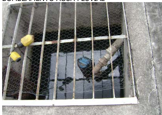
BOMBEAMENTO ÁGUA PLUVIAL
