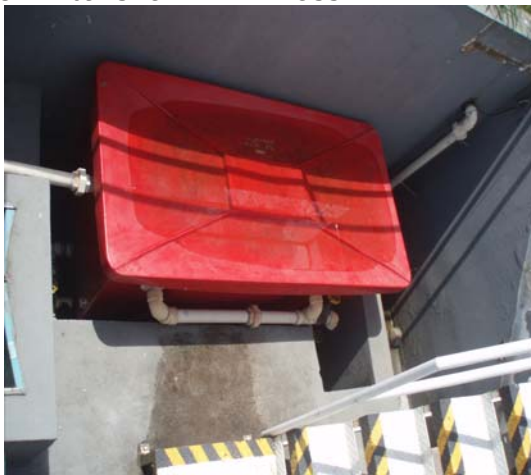
FIGURA 269. SAO AIR BP. FOSSA NA ÁREA DA EMPRESA ÉPICO
