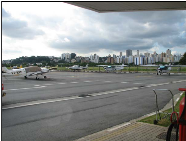
FIGURA 123. VISÃO PARCIAL DA PISTA E DO SETOR NORTE DO PÁTIO DA AVIAÇÃO GERAL. AZIMUTE 320°V
