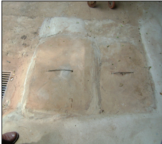
FIGURA 270. CAIXA DE GORDURA RESTAURANTE. ÁREA DE LAVAGEM DE AERONAVES TUCSON
