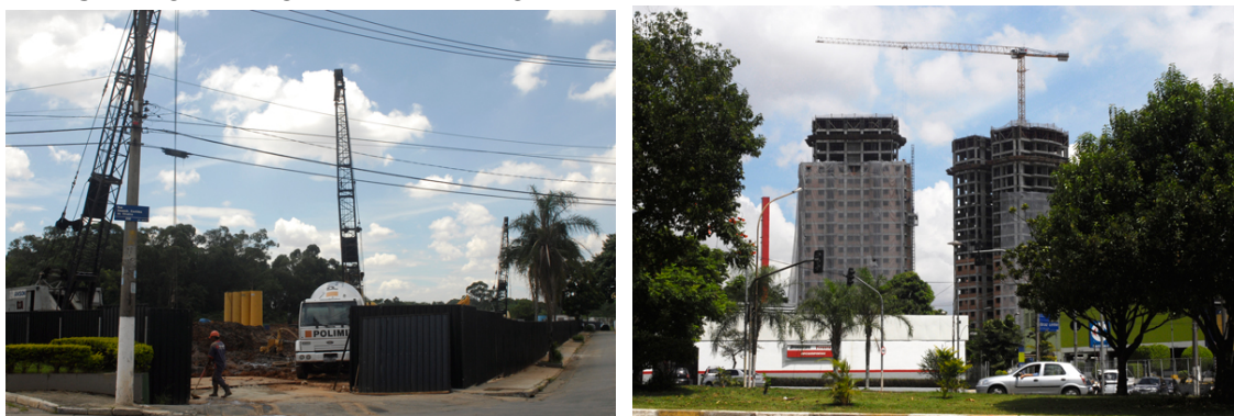
FIGURA 198. IMAGENS DE OBRAS PRÓXIMAS A CAMPO DE MARTE - A OESTE DO AEROPORTO - EM ÁREAS DE ZONA DE CENTRALIDADE POLAR B
