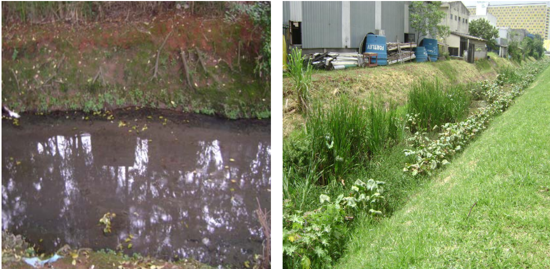
FIGURA 271 CÓRREGO TENENTE ROCHA ENTORNO DO AEROPORTO. CANAL DE DRENAGEM 3
