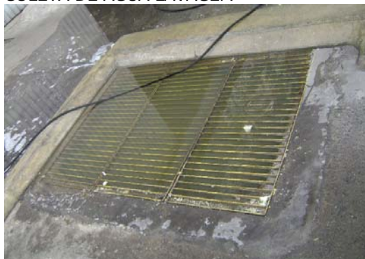
COLETA DE ÁGUA LAVAGEM
