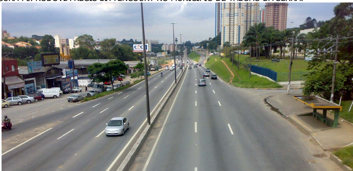
FIGURA 70. RODOVIA RÉGIS BITTENCOURT NO MUNICÍPIO DE TABOÃO DA SERRA.
