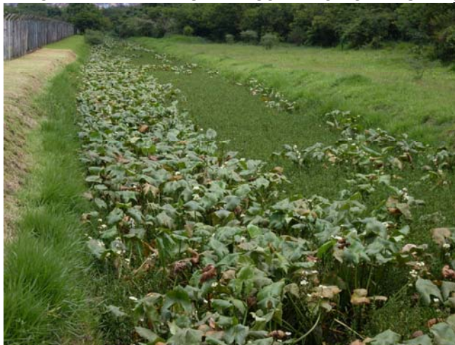
FIGURA 220 PRESENÇA DE CANAL DE DRENAGEM RECOBERTO POR VEGETAÇÃO AQUÁTICA.
