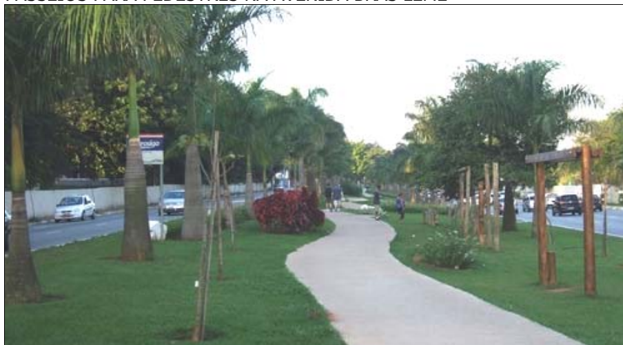
FIGURA 168 PASSEIOS PARA PEDESTRES NA AVENIDA BRÁS LEME
