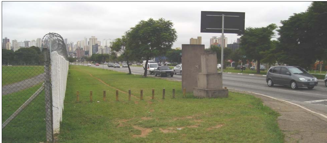
FIGURA 171 AUSÊNCIA DE PASSEIOS NA AVENIDA SANTOS DUMONT.
