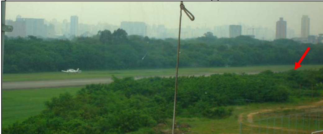
FIGURA 23. FIGURA 24. PISTA DE POUSO E DECOLAGEM VISTA A PARTIR DA TORRE DE CONTROLE – VEGETAÇÃO OBSTRUINDO A VISTA DA TOTALIDADE DA PISTA (2)
