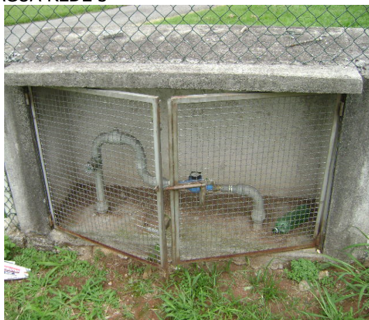
FIGURA 266. ENTRADA DE ÁGUA REDE 3
