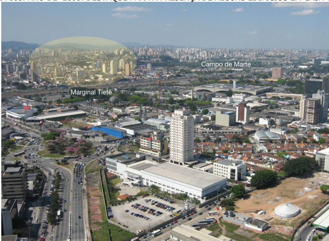
FIGURA 185. ANO DE 2008: DESTAQUE PARA A PRESENÇA DE ALGUNS EDIFÍCIOS EM CASA VERDE.
