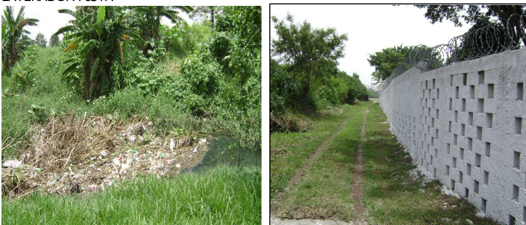
FIGURA 274. RESÍDUOS REPRESANDO A ÁGUA DE DRENAGEM E, ÁREA DE ALAGAMENTO NA LATERAL DA PISTA
