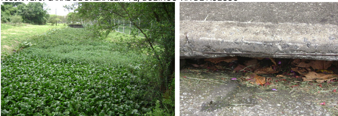
FIGURA 273. CANAL DE DRENAGEM 4 E, BUEIROS VIA DE ACESSO
