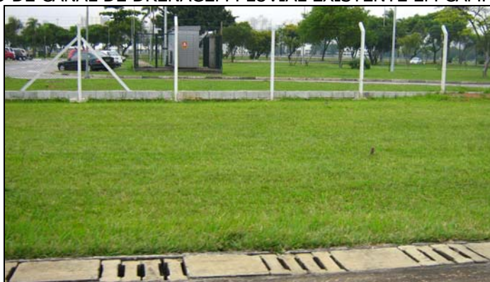
FIGURA 37. EXEMPLO DE CANAL DE DRENAGEM PLUVIAL EXISTENTE EM CAMPO DE MARTE
