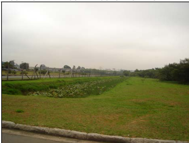
FIGURA 94. DRENOS DE ÁGUAS PLUVIAIS
