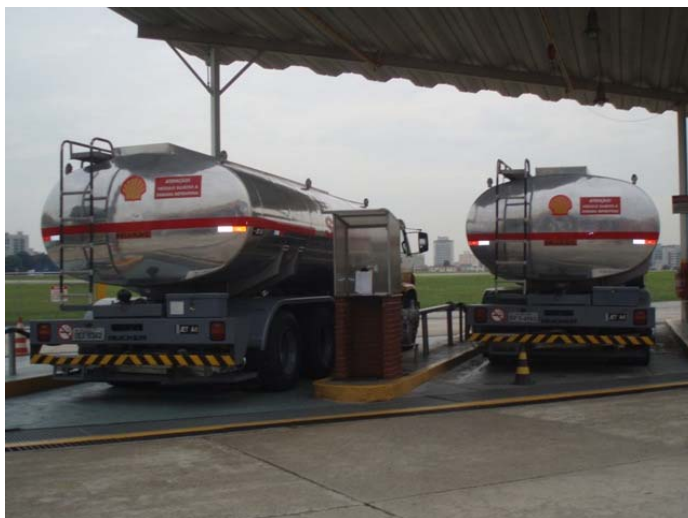
Figura 207: Baía de abastecimento para os tanques existe canaleta interligada com caixas de contenção, para recebimento de derramamento acidental de combustível. Fonte: VPC/Brasil, 2008.
