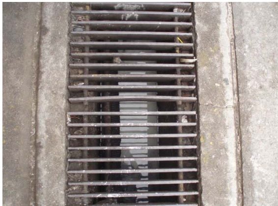
Figura 214: No Aeroporto de Congonhas, o atual sistema de drenagem lança os efluentes eventualmente contaminados por óleo diretamente na rede pluvial, sendo recomendável a instalação de uma caixa separadora água-óleo. Fonte: VPC/Brasil, 2008.
