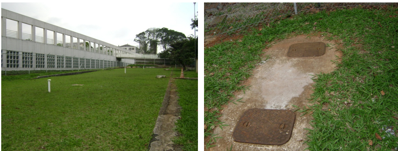
Figura 176: Reservatório de Água Principal e Poço Artesiano IFRAERO. Fonte: VPC/Brasil, 2008.
