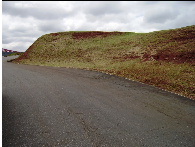
Figura 158: Aspecto do talude T3 no ponto 5, com deficiência de cobertura vegetal e solo parcialmente exposto.
