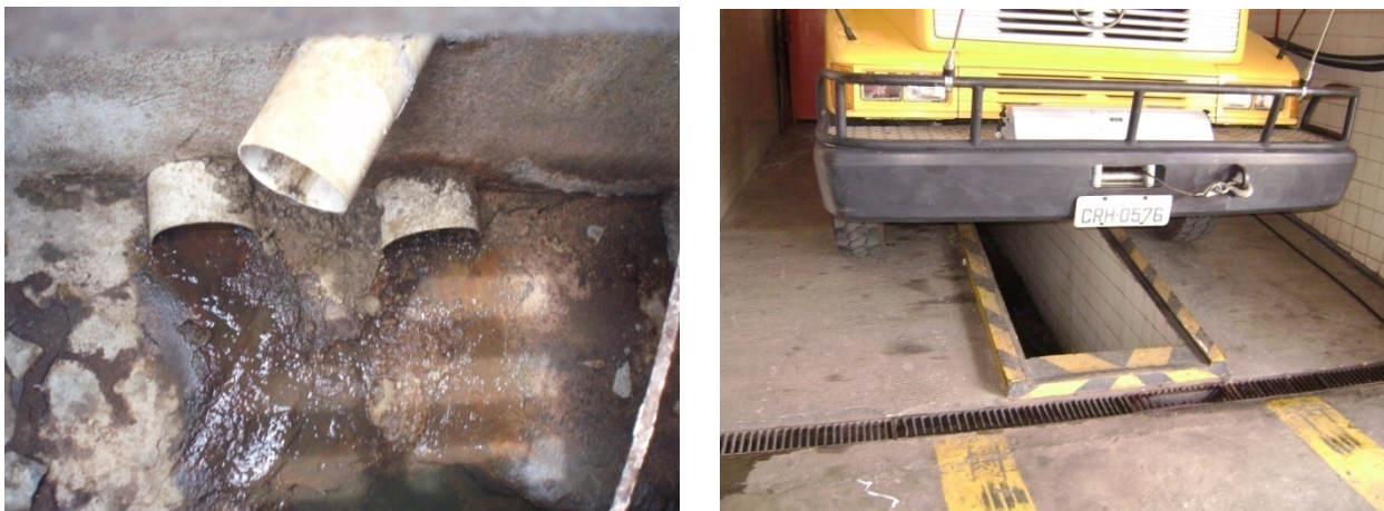
Figura 178: Tubulação da lavagem de veículos na Oficina e Box Oficina. Fonte: VPC/Brasil, 2008
