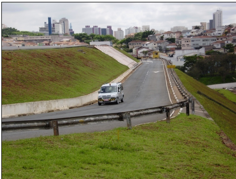
Figura 166: Detalhes dos taludes e patamares da Cabeceira 35L do aeroporto de Congonhas, como visto do ponto 1. À esquerda da foto observa-se uma porção do patamar inferior (P1), o talude (T2), o patamar (P2) capeado pela pista de asfalto onde está o veículo, o talude T3, que contém o quadriculado da cabeceira da pista e o patamar P3, correspondente à pista do aeroporto. Observar as canaletas de drenagem revestidas nos dois lados da pista, que impedem a infiltração da água no talude subjacente.
