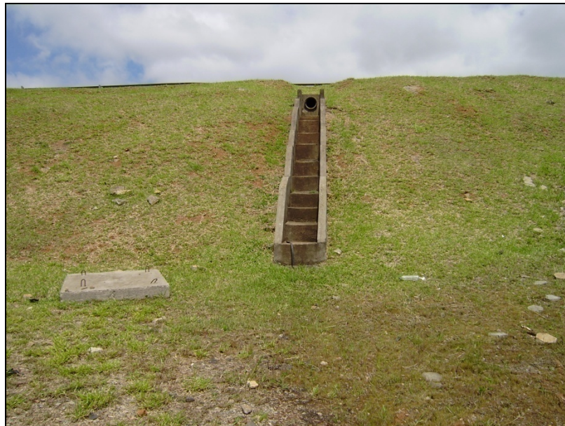
Figura 167: Canaleta de descida de drenagem, em escada, para diminuir a velocidade de escoamento da água das chuvas, recolhida da pista.
