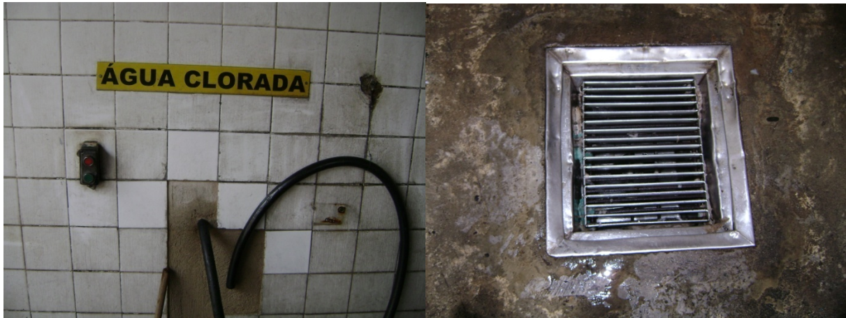
Figura 182: Grade Cloaca e Dosagem de Cloro na Cloaca. Fonte: VPC/Brasil, 2008.
