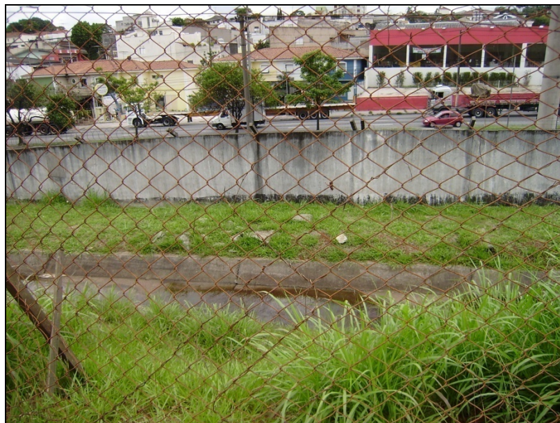
Figura 175: Principal canal coletor, no nível da Avenida dos Bandeirantes, que acumula toda a água retirada pelos drenos e canaletas de drenagem da porção nordeste do aeroporto de Congonhas. A fundo, veículos trafegando na Avenida dos Bandeirantes.
