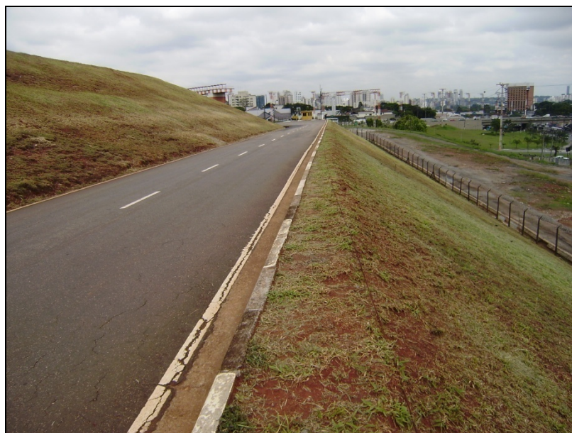
Figura 157: Aspectos do patamar inferior P1 (à direita, em nível inferior), do talude T2, P2 e T3 (à esquerda) da Cabeceira 17L e canaleta nos dois lados da pista, situada no P2.
