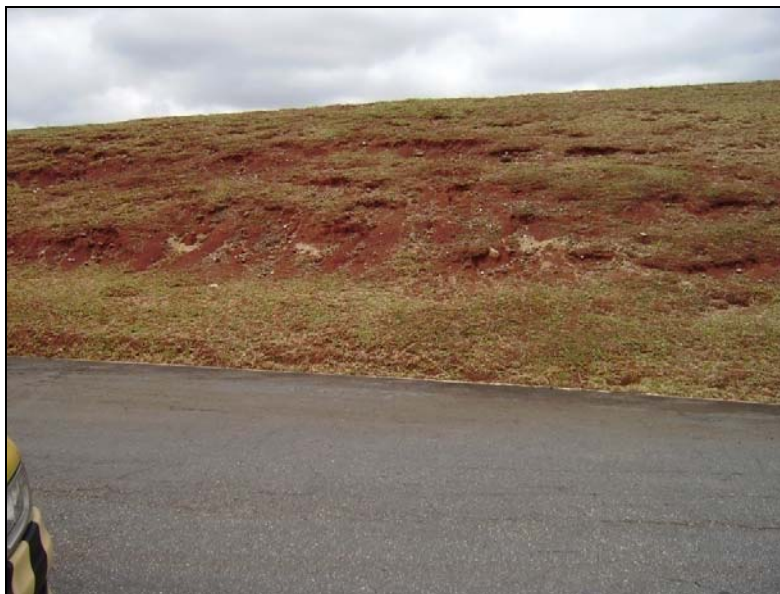
Figura 159: Aspecto do talude T3 no ponto 5. A deficiência de cobertura vegetal expõe o solo a processos erosivos por ocasião das chuvas.
