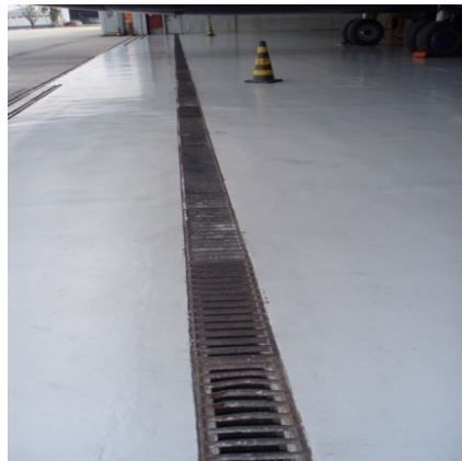
Figura 214: No Aeroporto de Congonhas, o atual sistema de drenagem lança os efluentes eventualmente contaminados por óleo diretamente na rede pluvial, sendo recomendável a instalação de uma caixa separadora água-óleo. Fonte: VPC/Brasil, 2008.
