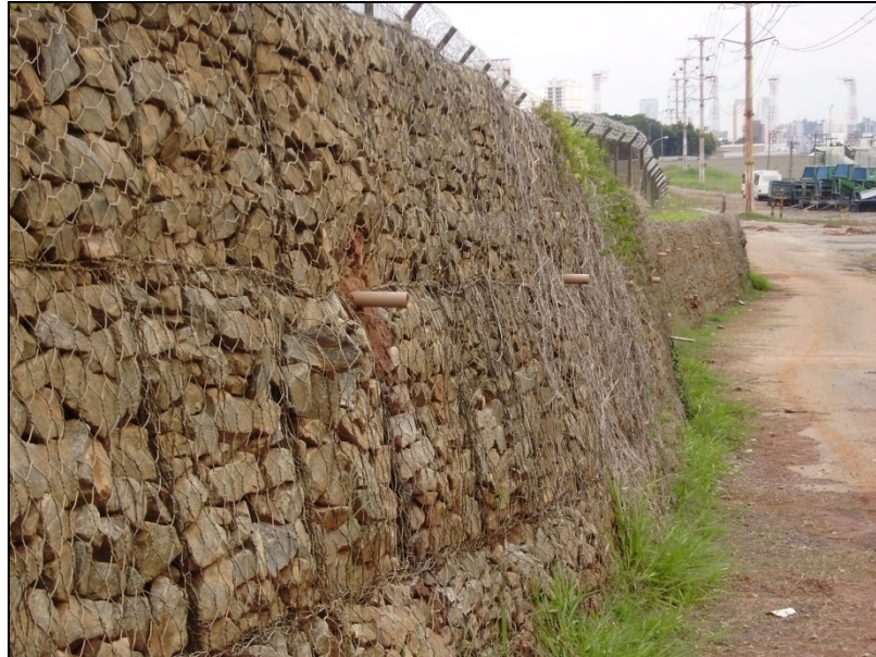
Figura 174: Muro de gabião e os drenos instalados no sopé do T1. O superior situa-se a 1,6 metros e o inferior a 50 centímetros de altura.
