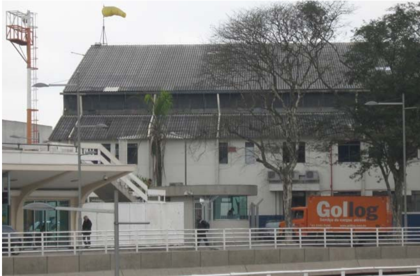
Figura 202: Portão Oeste e caminhão de transporte de mercadorias. Fonte: VPC/Brasil, 2008.
