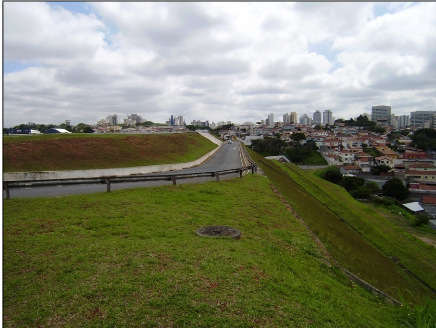
Figura 165: Aspecto dos taludes e patamares da Cabeceira 35L do aeroporto de Congonhas, como visto no ponto 1.
