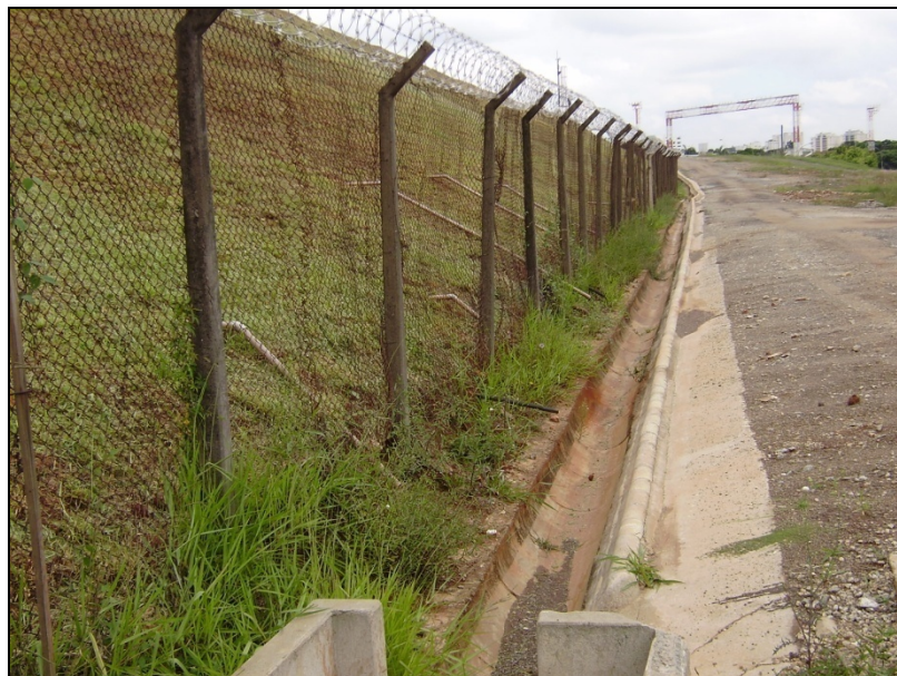
Figura 172: Drenos horizontais profundos instalados próximo ao sopé do T1, canaleta revestida e parte de caixa de drenagem, em primeiro plano.
