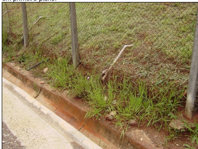
Figura 173: Drenos horizontais profundos instalados próximo ao sopé do talude 1 e canaleta revestida de drenagem.
