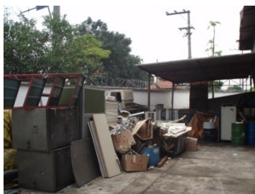
Figura 185: Disposição inadequada de material na oficina da INFRAERO. Fonte: VPC/Brasil, 2008.
