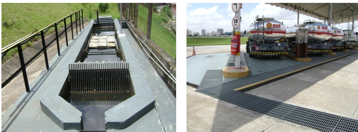
Figura 179: SAO do PAA e Canaletas de Drenagem. VPC/Brasil, 2008
