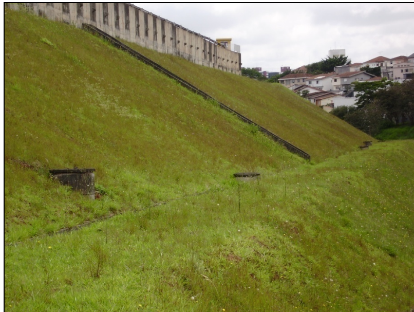
Figura 169: Detalhe do muro atirantado, canaleta em escada na parede frontal do talude e canaleta horizontal revestida no sopé do talude. Observar os poços de monitoramento da nível freático (tampas redondas).
