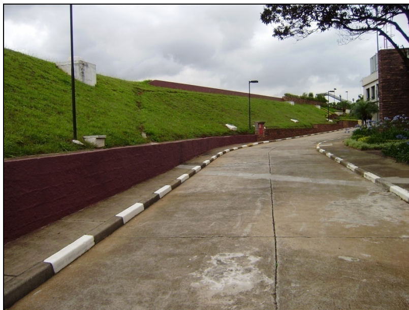
Figura 171: Talude e patamar no ponto 9, completamente estabilizado.
