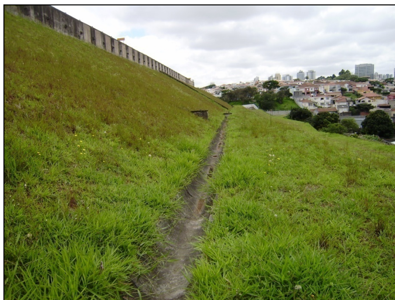
Figura 168: Muro de arrimo atirantado, talude vegetado e canaleta revestida no sopé do talude.
