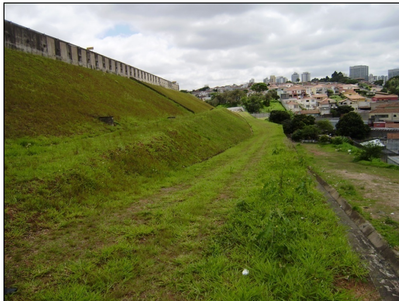
Figura 170: Diversos taludes e patamares da Cabeceira 35L e as diversas obras de estabilização e de contenção.
