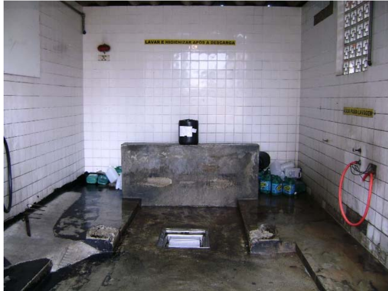
Figura 212: Cloaca para recebimento de rejeitos sanitários de aeronaves. Fonte: VPC/Brasil, 2008.
