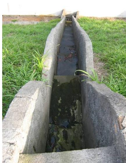
Figura 31: Taludes da cabeceira da Pista e escada de escoamento, sistema de drenagem. Fonte: VPC/Brasil 2008.
