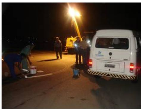
Figura 115: Obra de pintura de faixa no local indicado no croqui. Máquinas e veículos operando e trator e auto-gerador a diesel em operação. Fonte: VPC/Brasil, 2008.
