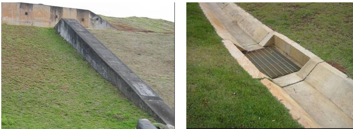
Figura 32: Canaleta de escoamento fechada, sistema de drenagem e canaleta de drenagem, no interior do aeroporto, sistema de drenagem. Fonte: VPC/Brasil 2008.
