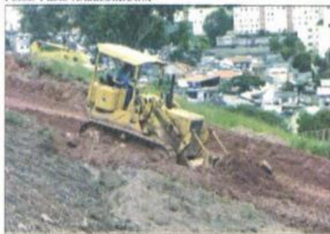
Máquinas trabalhando na terraplanagem do local
