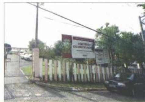
Placa instalada evidencia a futura instalação do CEU no local
