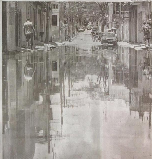
Rua Manoel Martins de Melo, no Jardim Pantanal, é uma das vias que estão alagadas há 15 dias, segundo moradores; bomba da prefeitura não dá conta
