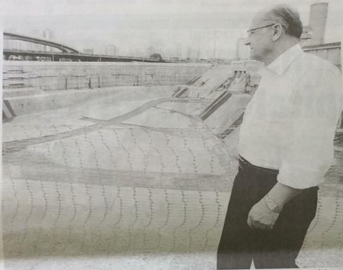
O governador Geraldo Alckmin (PSDB) observa o piscinão Guamaranga, na Vila Prudente (zona leste), às margens do rio Tamanduaé; reservatório vai comportar até 850 milhões de litros de água durante chuvas
