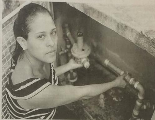
■ A dona de casa Talita Ariane, 25 anos, mostra saída do gás, que está cortado por causa do desmoronamento; ela está dormindo no salão de festas do prédio
