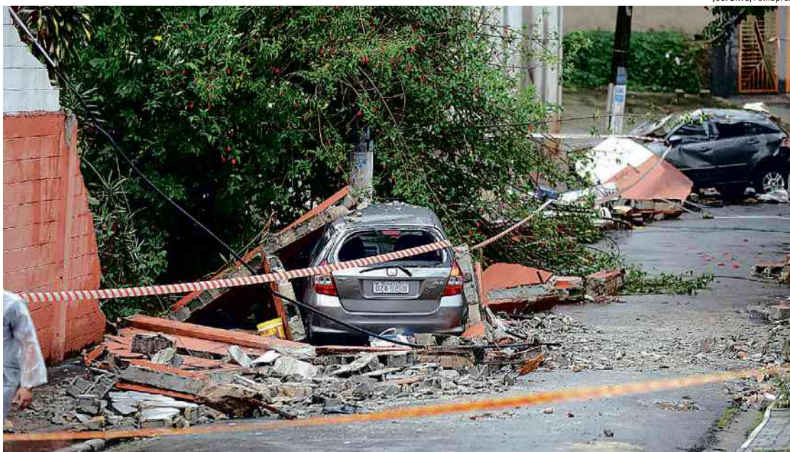
Carro destruído após desabamento de muro em uma chácara na zona leste de São Paulo onde ocorria festa universitária
