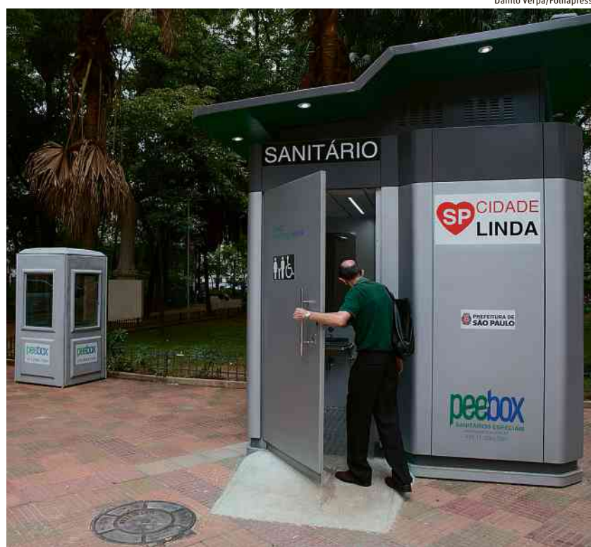
Banheiro da prefeitura instalado na praça Dom José Gaspar, no centro de São Paulo
