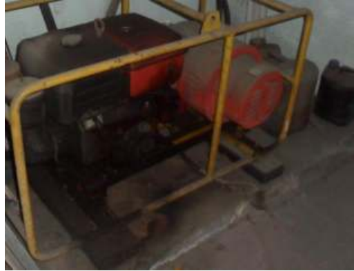
Figura 2: Mancha abaixo de equipamento.
