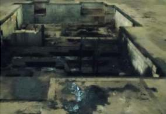
Figura 1: Estrutura de um antigo tanque com vestígios de óleo provavelmente utilizado para lavagem ou banho em peças de metal.
