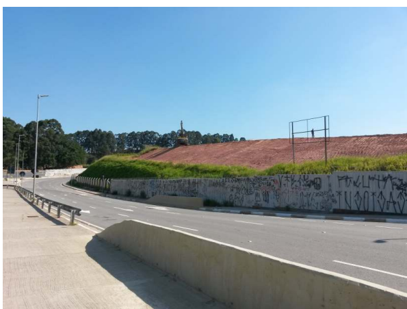
Vista externa da reconformação do talude.
