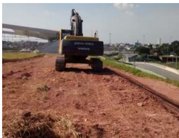
Vista interna da fase final da reconformação do talude.
