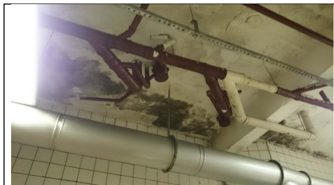
Imagem 13 - Exposição de rede de esgoto.
