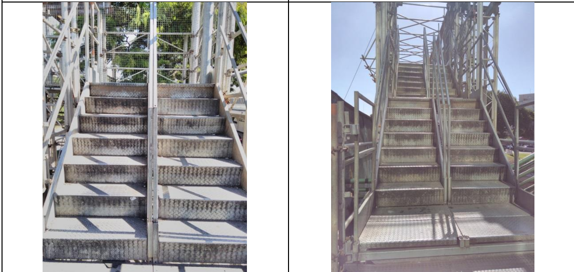
Figuras 15 e 16: Escadas de acesso à passarela.
