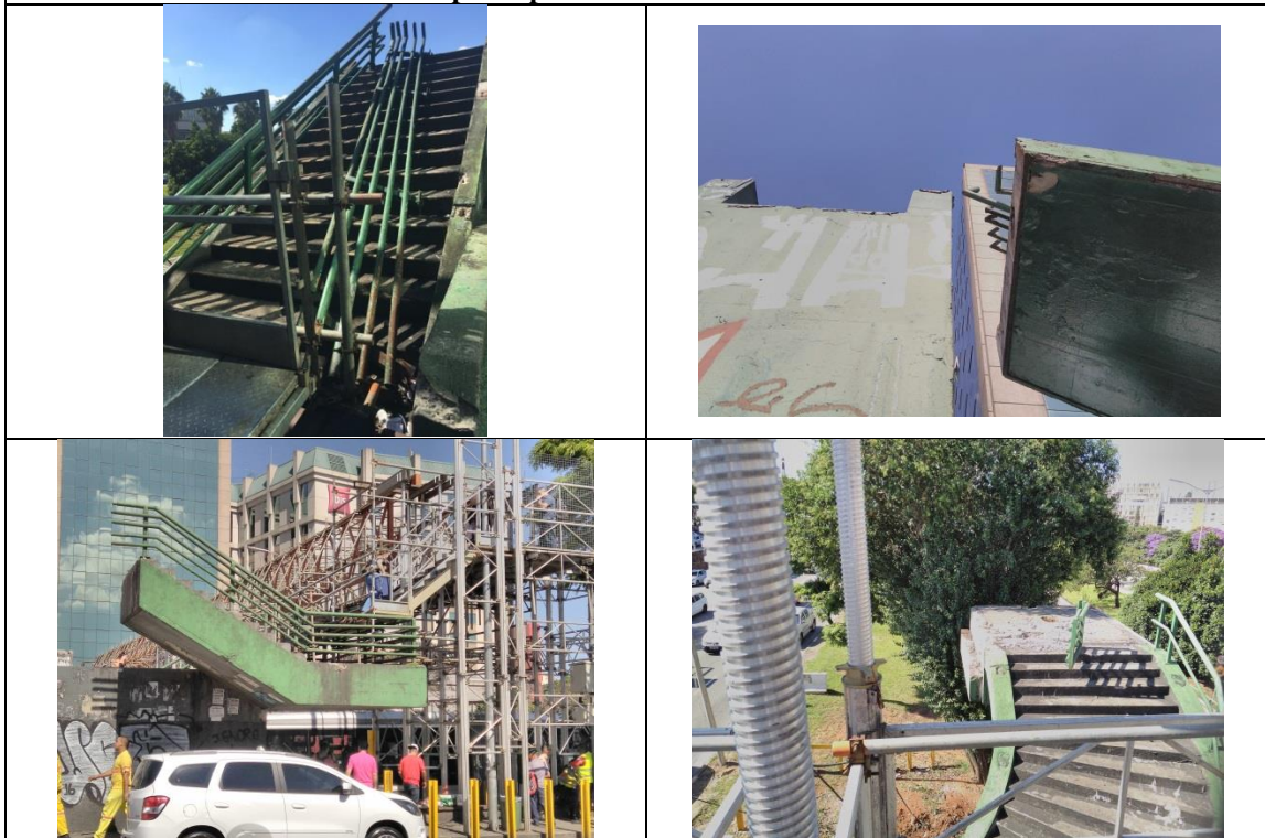
Figuras 9, 10, 11 e 12: Falta de isolamento, sinalização e proteção de estrutura comprometida da ponte parcialmente demolida.
