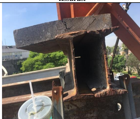
Figura 14: Apoio de madeira das treliças com fissuras.
