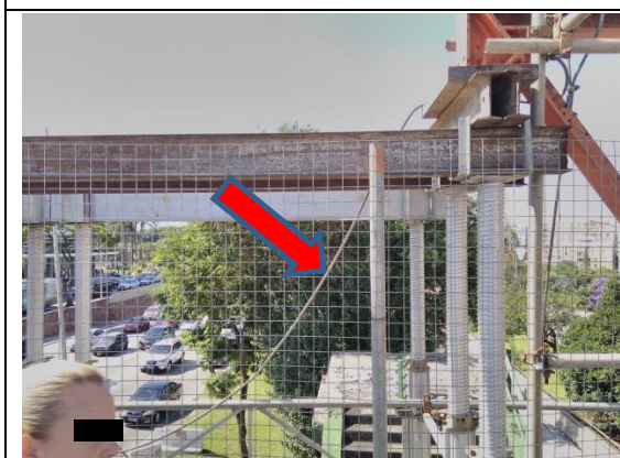
Figura 13: Cabos não tensionados
