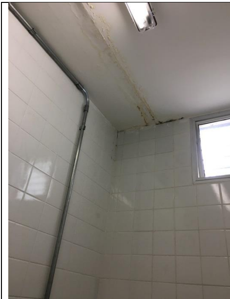
Figura XIV – Infiltração – Sanitário masculino
