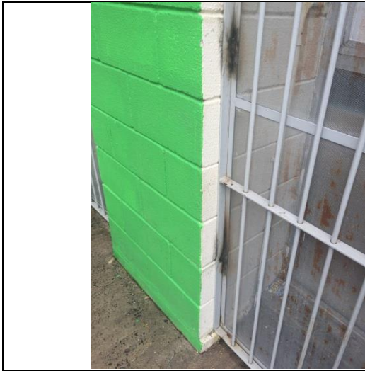
Figura IX – Tela mosquiteiro e grade de proteção enferrujados
