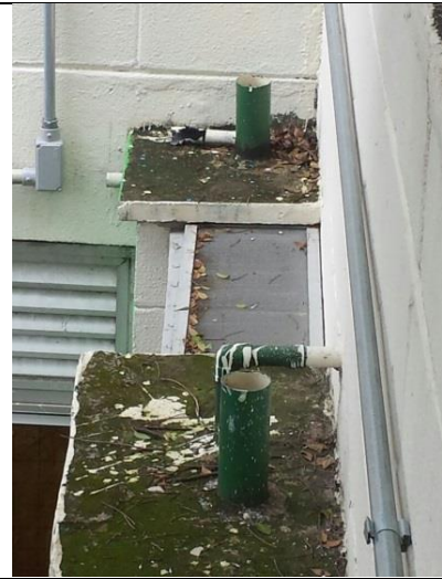
Figura X – Falta de grades de proteção
