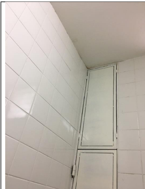
Figura XVI – Infiltração – Sanitário feminino
