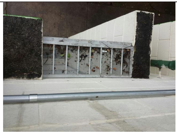
Figura XII – Fixação irregular da grade de proteção
