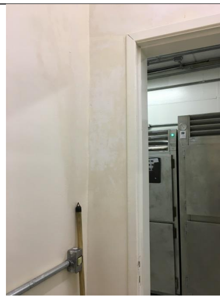
Figura XIX – Infiltração
