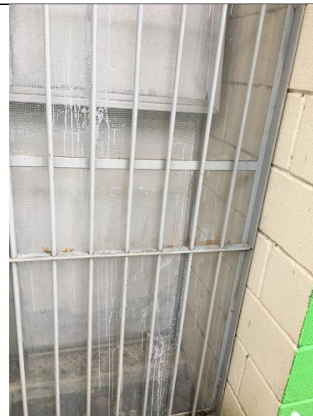
Figura XXI – Má execução da pintura
