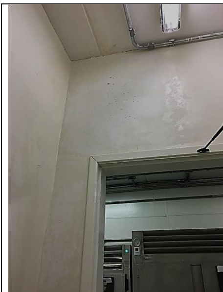
Figura XVIII – Infiltração
