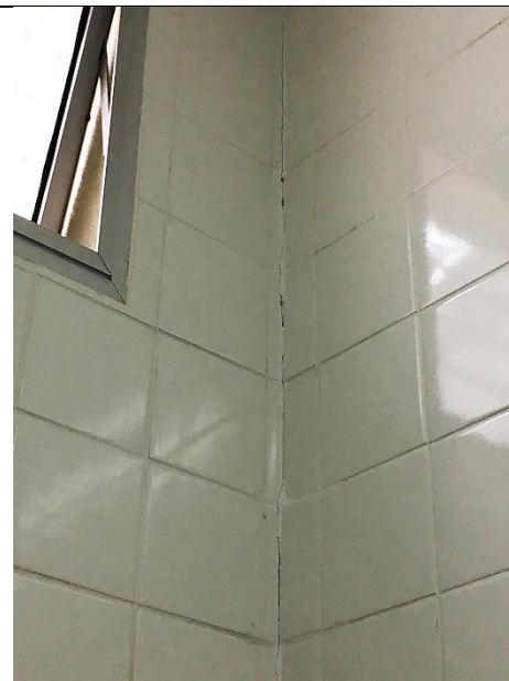
Figura XVII – Rachaduras no azulejo – Sanitário feminino
