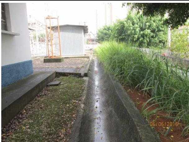
**Foto 11:** Detalhe do sistema de drenagem superficial instalado no interior da ETD Gomes Cardim.
