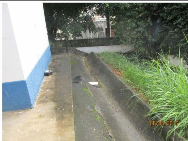
**Foto 10:** Detalhe do sistema de drenagem superficial instalado no interior da ETD Gomes Cardim.
