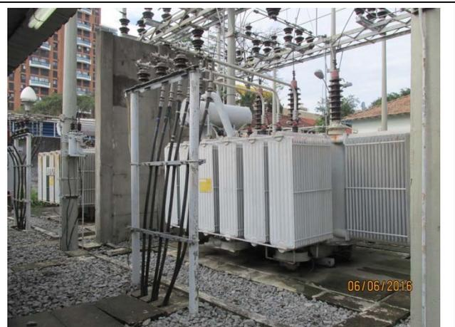
**Foto 06:** Detalhe dos transformadores que serão substituídos.
