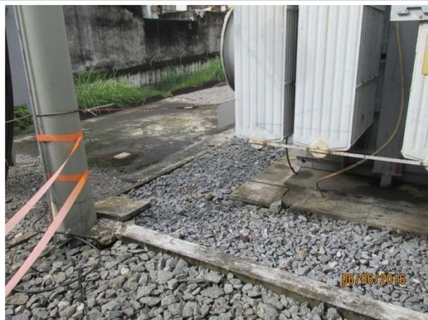
**Foto 08:** Caixa separadora de água e óleo instalada no interior da ETD Gomes Cardim.
