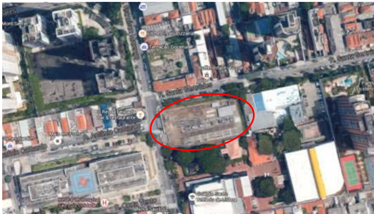
Figura 1 – Localização da subestação ETD Gomes Cardim
