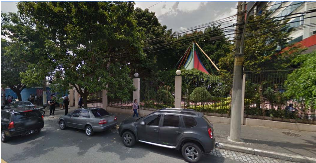
Figura 3: Rua Francisco Marengo – Vizinhança ao lado da subestação ETD Gomes Cardim
