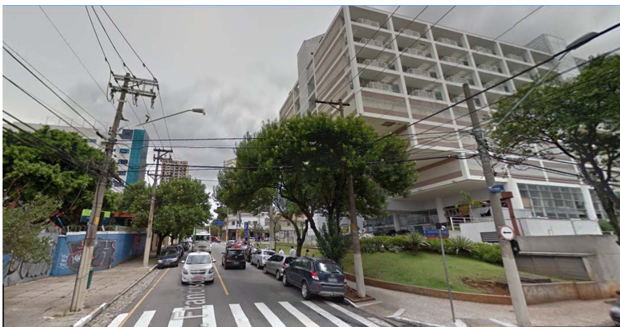
Figura 2: Rua Francisco Marengo – Vizinhança de frente a subestação ETD Gomes Cardim
