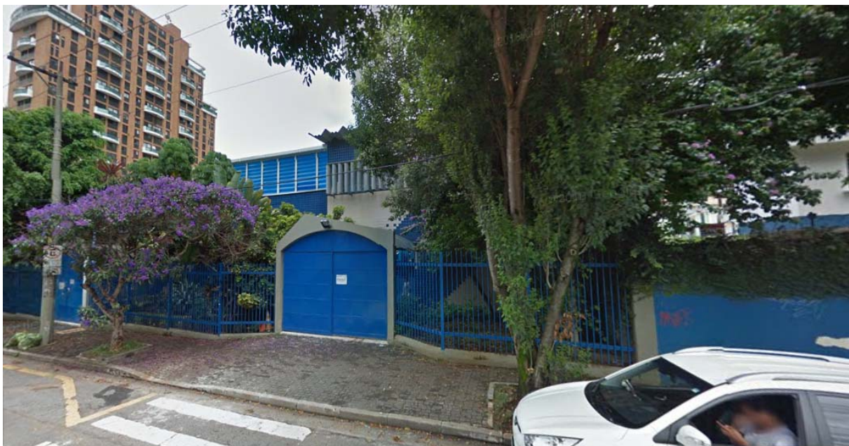
Figura 5: Rua Santa Gertrudes – Vizinhança ao lado da subestação ETD Gomes Cardim
