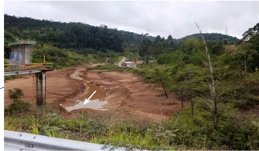
Córrego Guaraú, a jusante da ETA do Guaraú e a montante da Barragem de Contenção
