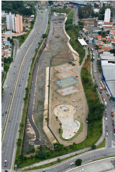
Vista de jusante para montante
