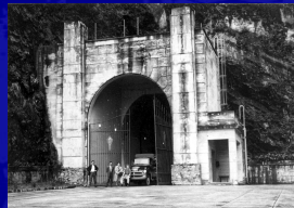
ENTRADA DA USINA SUBTERRÂNEA - HENRY BORDEN II - 1956
