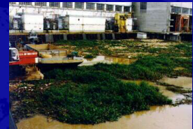
USINA ELEVATÓRIA TRAIÇÃO - RETIRADA DE RESÍDUOS E PLANTAS AQUÁTICAS
