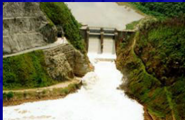
ESPUMAS SURFACTANTES BARRAGEM DE PIRAPORA -2005
